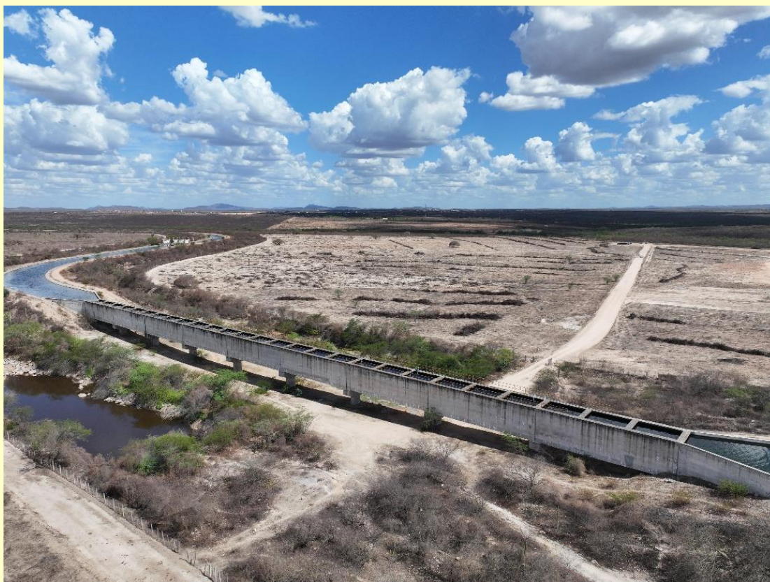
Figura 2: Área de supressão vegetal para construção do canal do sertão no município de Delmiro Gouveia.
