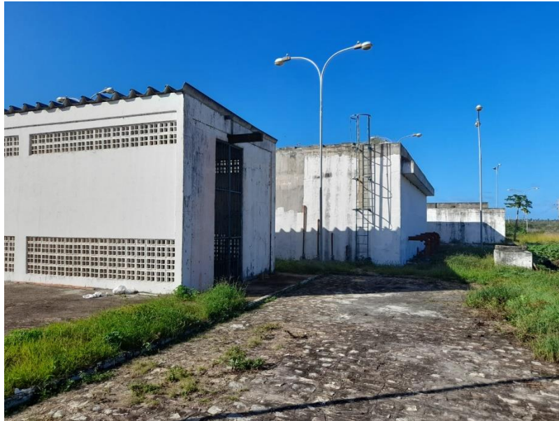
Figura 1 – Estação de Tratamento de Esgoto – ETE/ Marechal Deodoro
