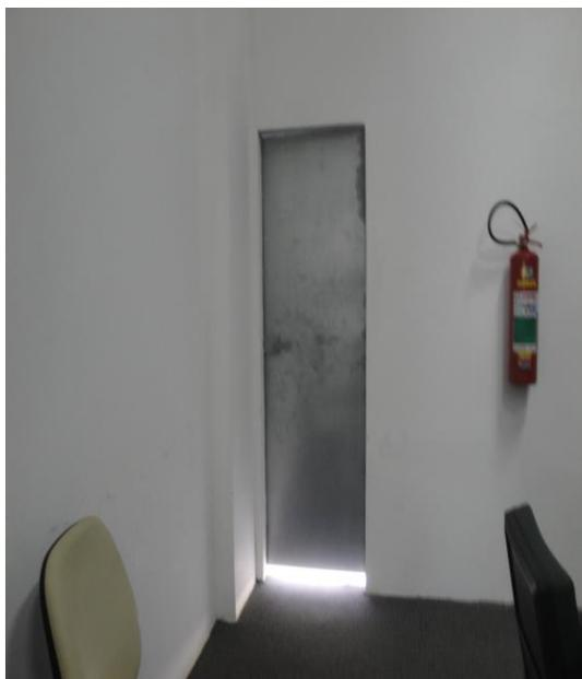
Parede será demolida para adequação das dimensões da saída de emergência do auditório.
