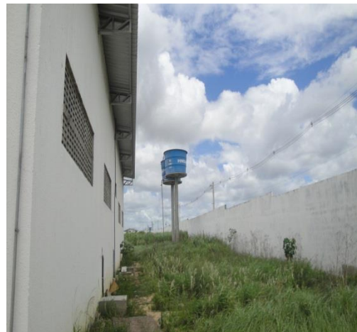
Reservatório instalado no local
