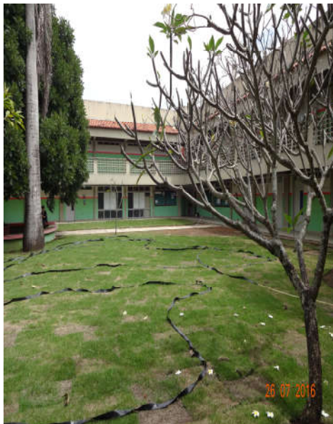
Área livre do bloco administrativo
