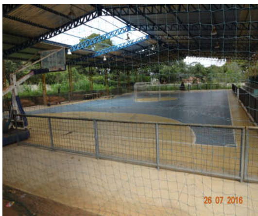
Será instalado guarda-corpos nas extremidades da arquibancada do ginásio e parte da cobertura ausente será instalada.
