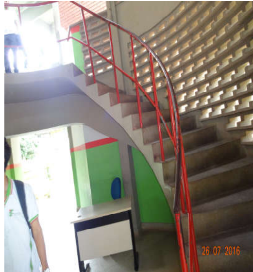
Guarda-corpos onde serão instaladas telas
