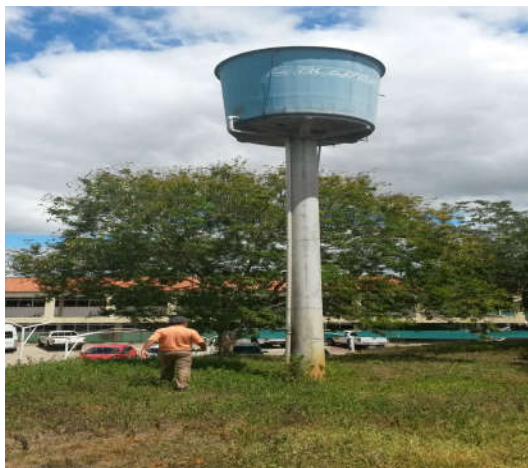
Estrutura de concreto com caixa d'água.
