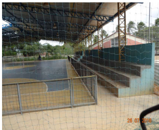
Será instalado guarda-corpos nas extremidades da arquibancada do ginásio e parte da cobertura ausente será instalada.
