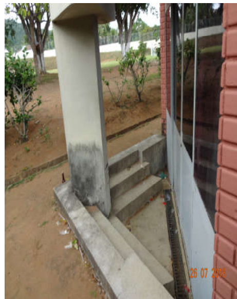
Área lateral do auditório onde será construída a rampa
