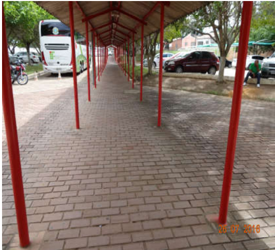
Acesso da entrada da edificação do Campus
