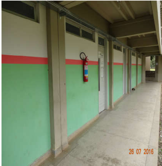
Área de passagem dos eletrodutos
