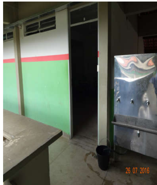
Área onde será instalado o abrigo com hidrante
