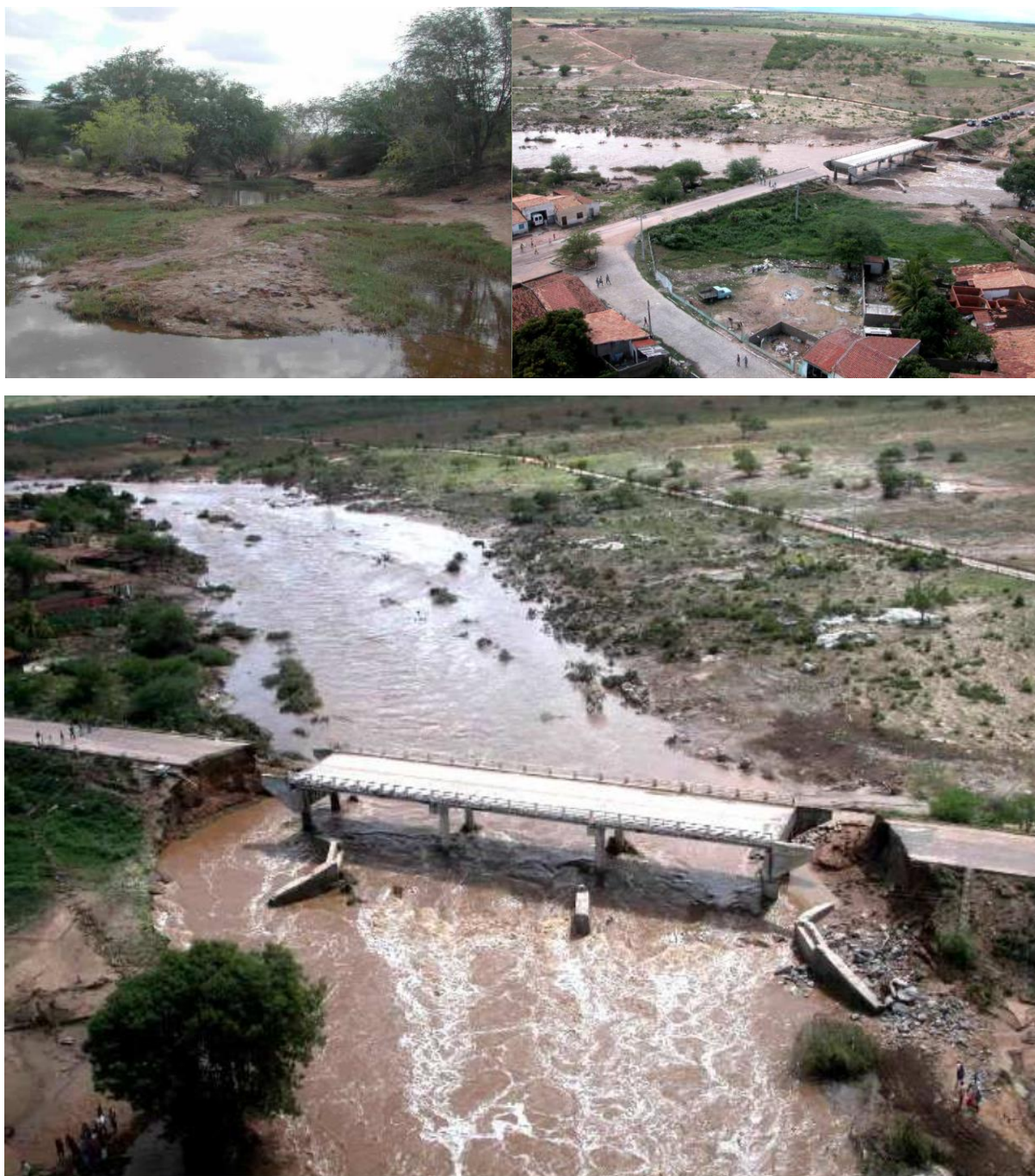
Figura 11 – Assoreamento do Rio Jacaré e danos em ponte por enchente
