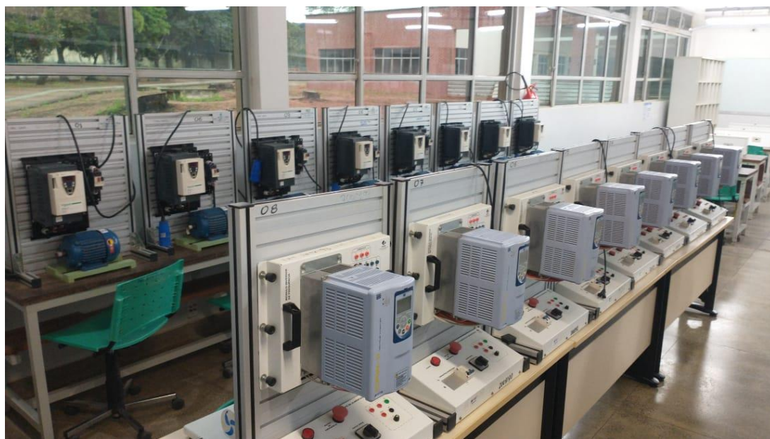
Figura 1-Laboratorio de instalações elétricas / eficiência energética
