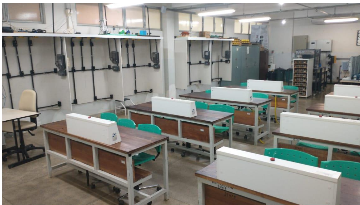
Figura 3-Laboratorio de instalações elétricas / eficiência energética
