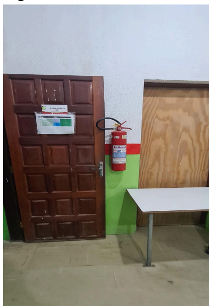
Figura 1: extintor de incêndio
