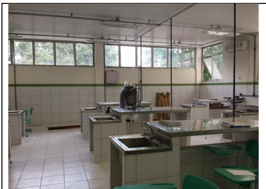
Figura 11 - Ar condicionado instalado fora de uso, Maceió (AL), 01 de outubro de 2015.
